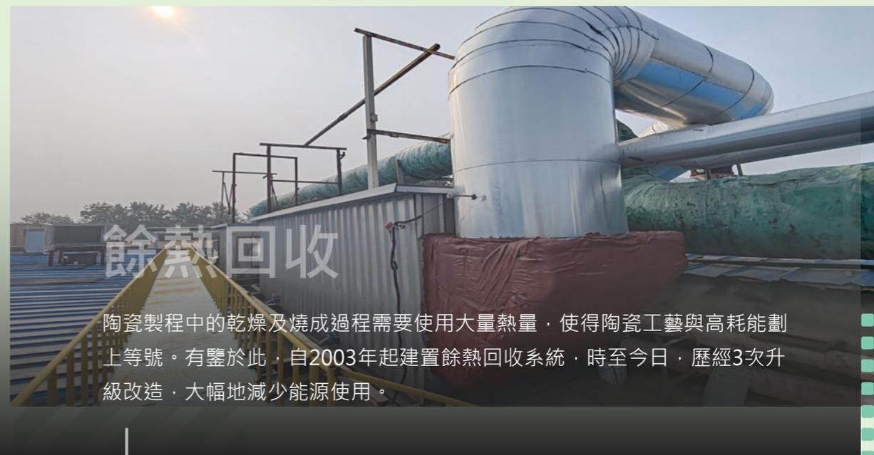
陶瓷製程中的乾燥及燒成過程需要使用大量熱量，使得陶瓷工藝與高耗能劃上等號。有鑒於此，自2003年起建置餘熱回收系統，時至今日，歷經3次升級改造，大幅地減少能源使用。
