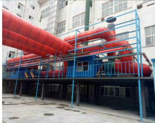
圖、窯爐餘熱系統
