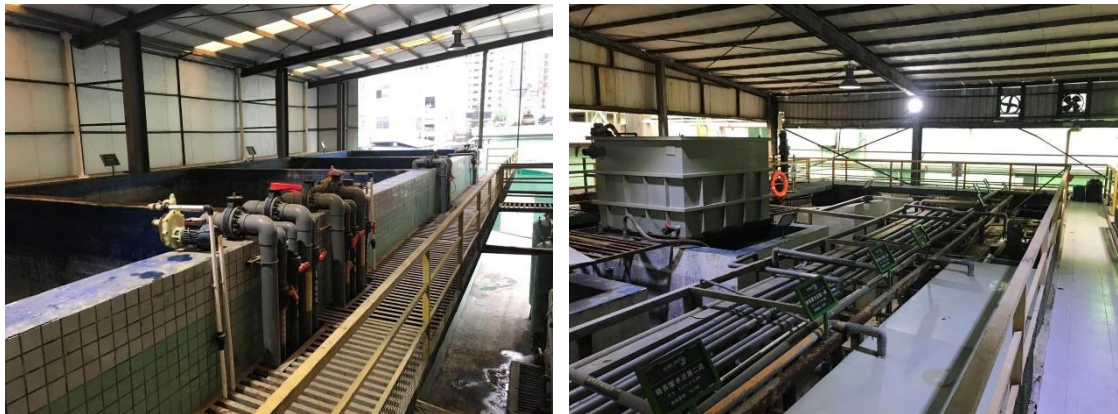
圖、深圳廢水處理區
